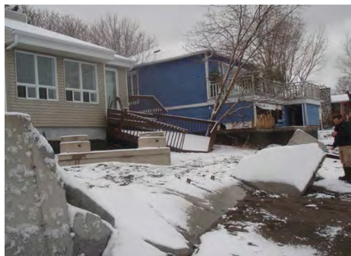
Résidences endommagées à la suite de la tempête du 6 décembre 2010 à Sainte-Luce dans le Bas-Saint-Laurent. Crédit photo : UQAR-DGIZC
