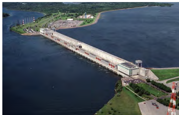
Barrage Moses-Saunders, à Cornwall, entre le lac Ontario et le fleuve Saint-Laurent Crédit photo : CMI
