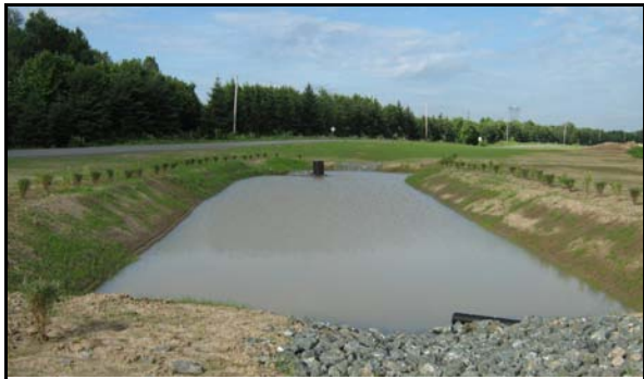
Bassins #3 (b.v. 245 ha): * 12 m x 50 m x 2 m * Etang humide: 9 m x 47 m x 1 m; surface: 423 m 2 ; stockage: 350 m 3 * Etang sec: (comprenant la voie d'eau) lorsque le niveau d'eau atteint l'extrémité de l'avaloir: 1800 m 2 ; stockage: 1400 m 3
